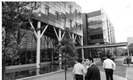
▶ サイバージャヤのデータセンター
